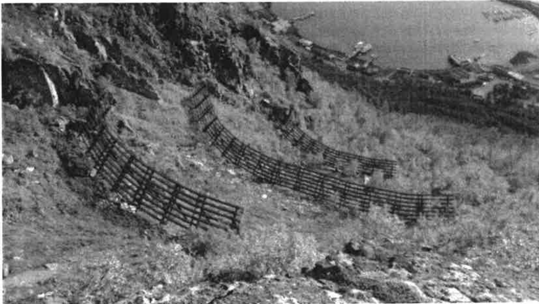
Figur 16. Oversiktsbilde av støtteforbygninger
