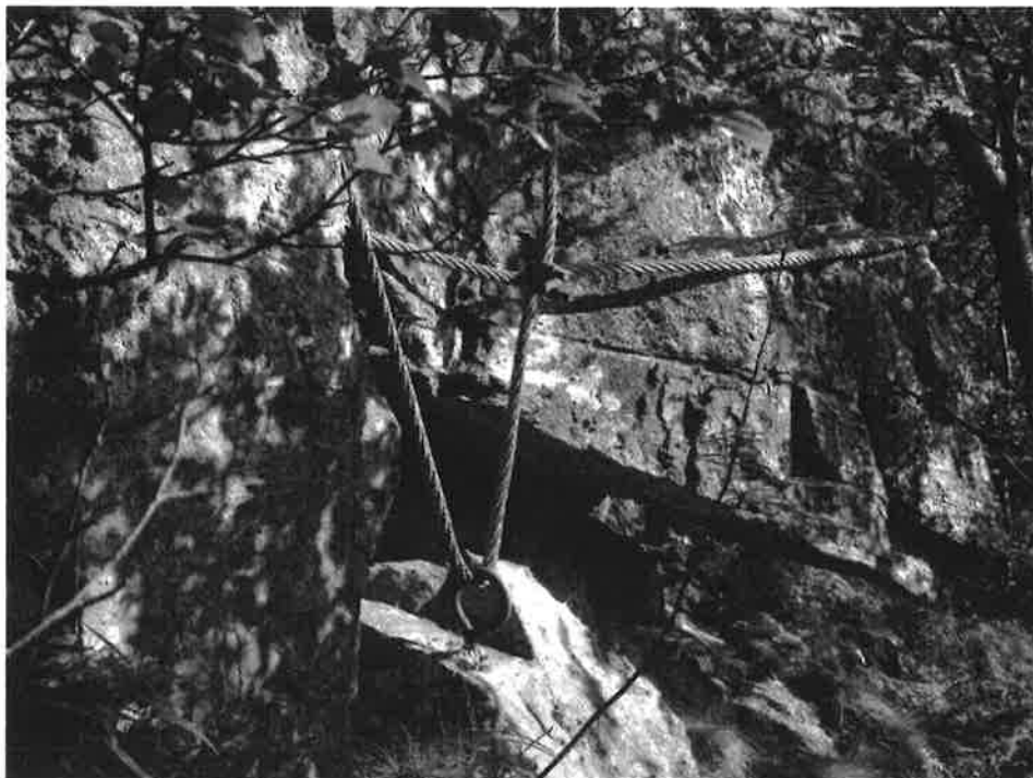
Figur 6. Sikring av avløst blokkparti ved Platået nr 7.
