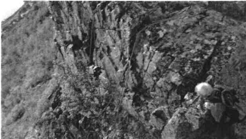
Figur 13. Løsthengende sikringswirer på den sørlige av Hornet
