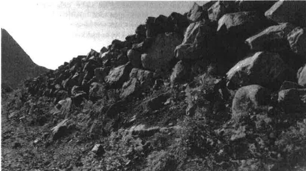
Figur 15. Oppsiden av sikringsvollen
