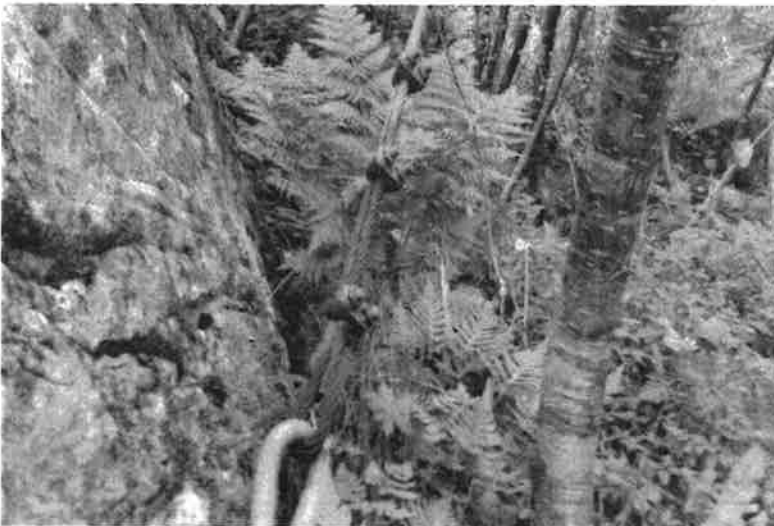
Figur 4. Korrosjon på sideforankring
